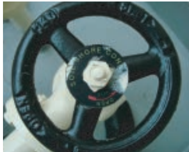
カラー弁銘板〔暴露部〕 材質：SUS430 0.5t
