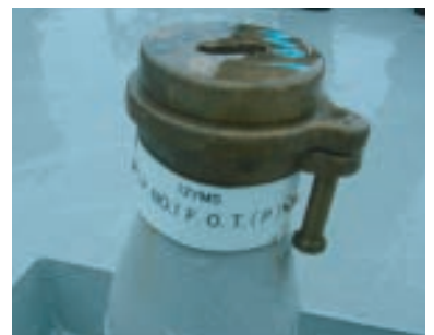
一般名称板〔暴露部〕 材質：SUS430 0.5t
